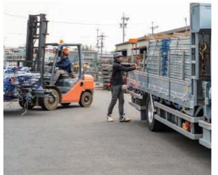
機材部では、次の現場に必要となるさまざまな工事用機材（足場）をセンターからフォークリフトで集め、トラックに載せる準備をします。また持ち帰ってきた部材をメンテナンスし元のヤードに戻す業務も行います。現場からのリクエストに応じ部材を加工してオリジナルのバーツを作る事もあります。
