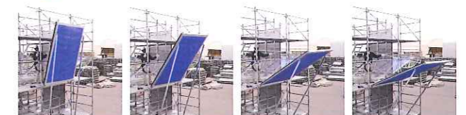
ロープを用いて本体を倒し、角度調整後、固定(適正角度=26度)します。ロープを足場に緊結します。
