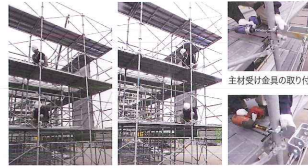
主材受け金具、斜材受け金具をクランプで取り付け 斜材受け金具の取り付け
