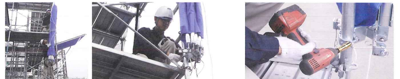
本体に取り付いている主材受け金具を建地に取り付けます。コーナー本体は折りたたんだ状態で取り付けます。
