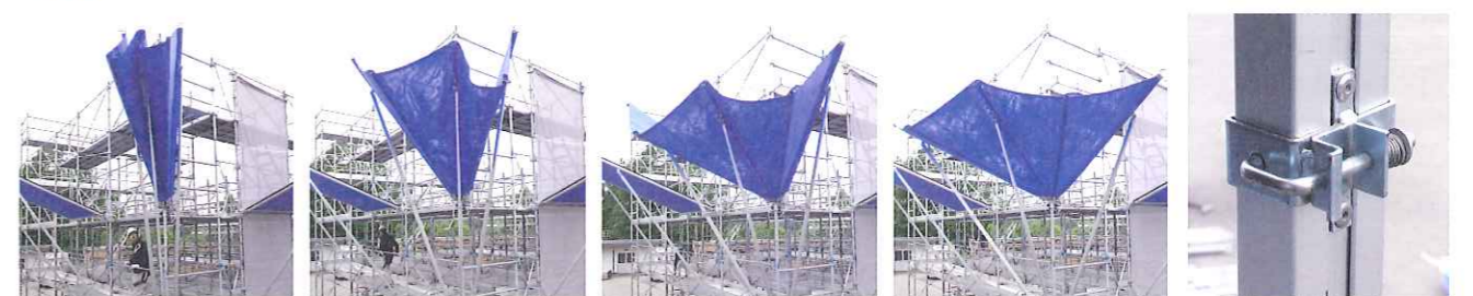
ロープを用いて本体を倒し、角度調整後、固定(適正角度=26度)します。ロープを足場に緊結します。
