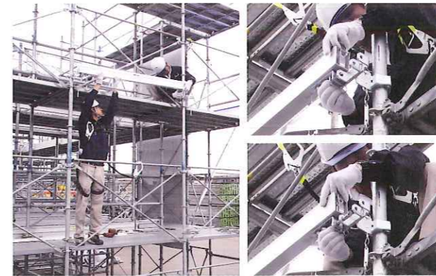
ボルトを左2本・右2本、縦枠側合計4本を取り外します。下枠を主材受け金具に置き、主材受け金具のグラビティピンを差し込みます。
