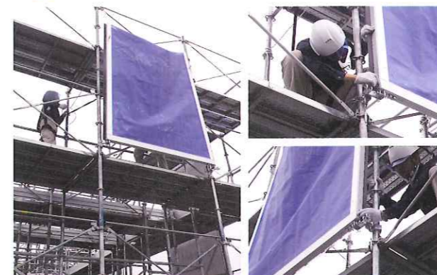
下枠の突起にシート両端部のパイプを差し込みます。本体シートセット挿入後、縦枠側に左2本、右2本の合計4本を縦枠側にボルトを差し込みます。
