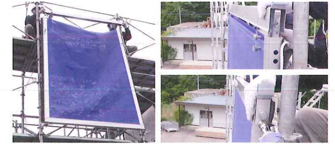
ボルトを左2本・右2本、縦枠側合計4本を取り外し、上枠の突起をシート縦枠部のパイプに差し込みます。上枠を縦枠部挿入後、左2本、右2本の合計4本を縦枠側にボルトを差し込みます。
