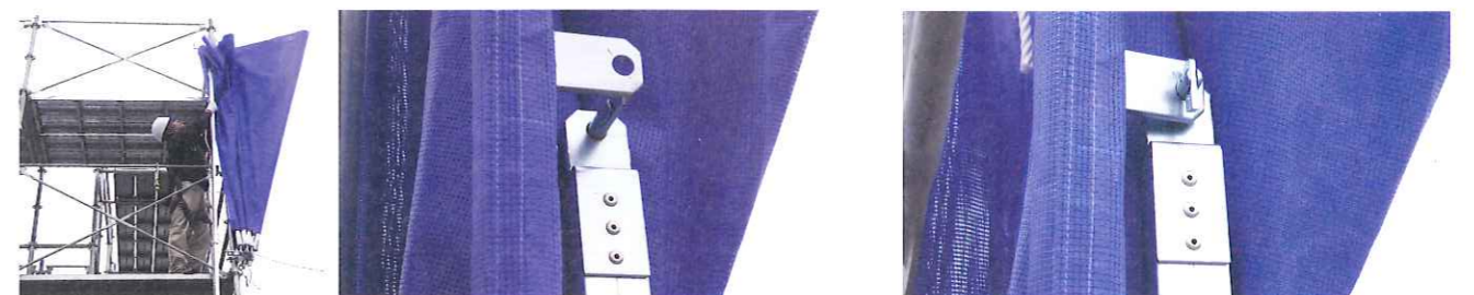
斜材は中央と両端に取り付けます(3本/体)。斜材は全て同じ向きで取り付けてください。本体の金具と斜材受け金具に斜材をグラビティピンを用いて取り付けます。
